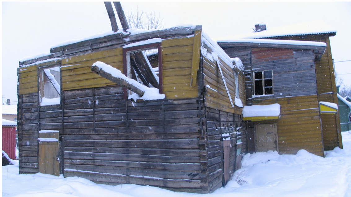
Foto 1. Vaade Herne 45, 47 hoone hoovipoolsele lammutatavale osale.
